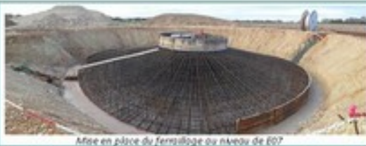
Mise en place du ferrailage au niveau de E07
